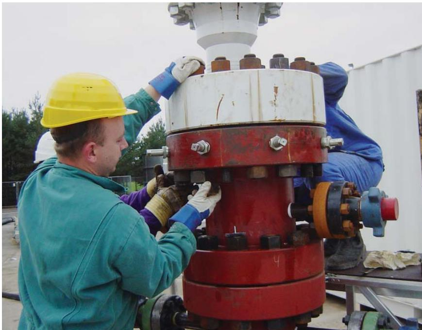
Abb. 9: Arbeiten am Bohrlochkopf
