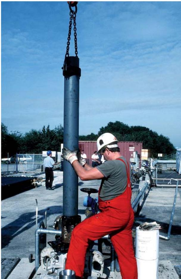
Abb. 41: Einbau der Pumpe in die Tiefbohrung GB2
