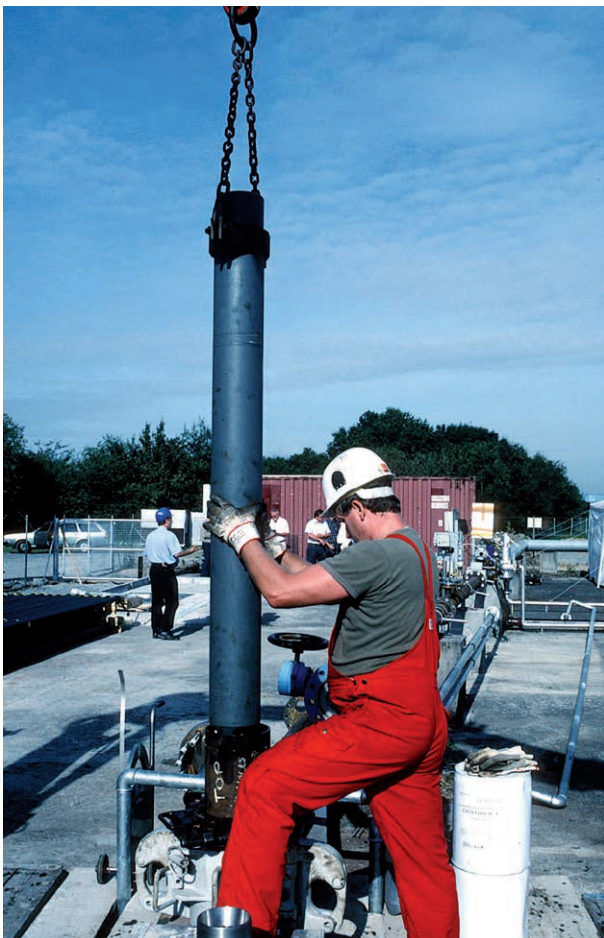
Fig. 41: Instalación de una bomba hidráulica en el pozo GB2 (Bruchsal)
