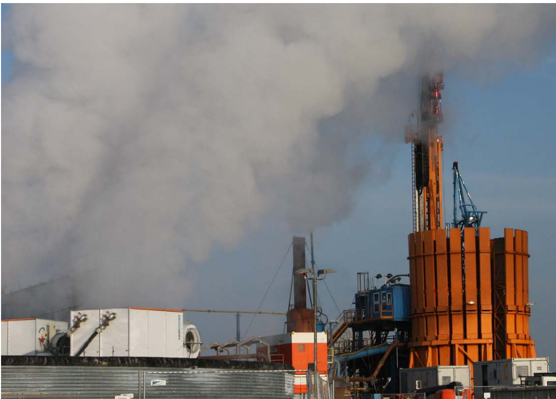
Fig. 43: Prueba de bombeo en la perforación TH 4 en Unterföhring (© GEOVOL Unterföhring GmbH)
