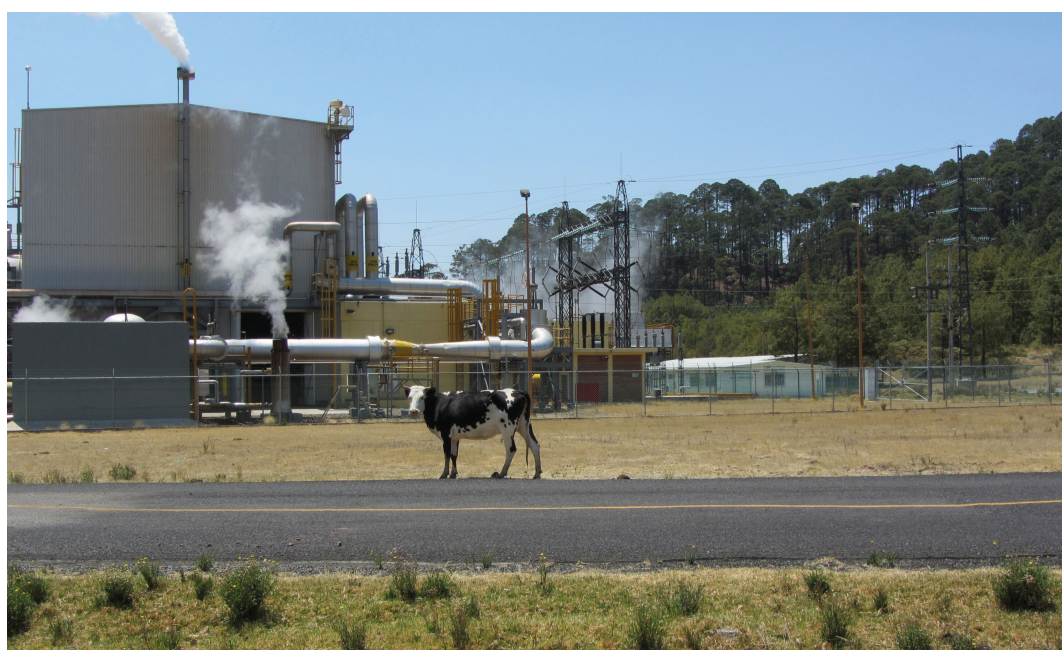
Figure 12: Los Azufres geothermal power plant, Mexico.
